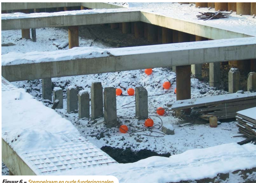
Figuur 6 – Stempelraam en oude funderingspalen.
