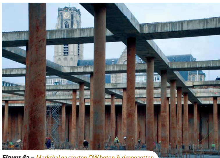
Figuur 4a – Markthal na storten OW beton & droogzetten.
