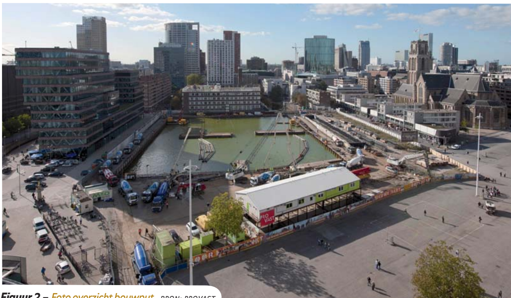
Figuur 2 – Foto overzicht bouwput. BRON: PROVAST
